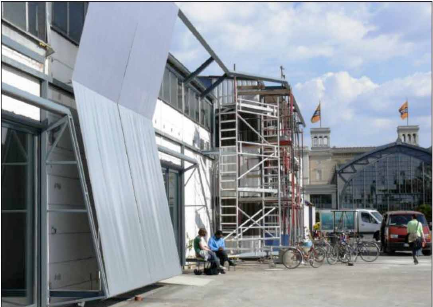
...außen noch im Bau: Halle am Wasser - im Hintergrund rechts der HAMBURGER BAHNHOF - Foto:
